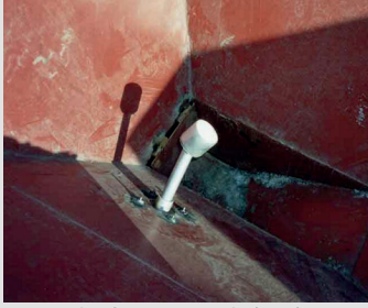
Armsonde FSA in einem Silo (Leer)
