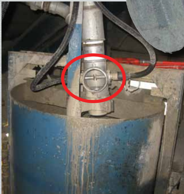
Abb.: 2,5" Restwasser-Leitung - Einfache Rohrmesskopf-Ausführung mit schraubbarem Verschluss zur Wartung
