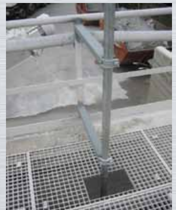
Angeschweisste Gerüstschellen mit bereits montiertem Halterungsrohr zum OLAS-Messkopf
