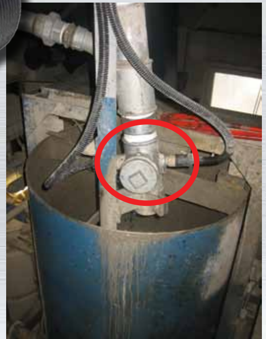
Abb.: 2,5" Restwasser-Leitung - Einfache Rohrmesskopf-Ausführung mit schraubbarem Verschluss zur Wartung
